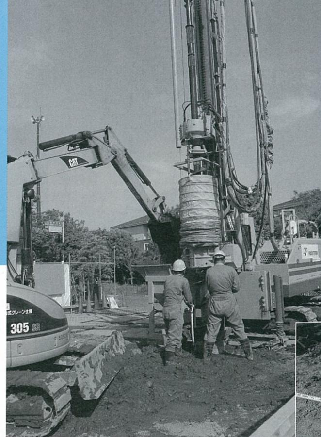
左の写真は、施工機に碎石を投入している様子。下のイラストの③に該当する。宅地用に新たに開発したこの施工機では、深さ約10mまで削孔できる。敷地面積は約50坪以上必要だ。下の写真は完成した碎石の柱状改良体の杭頭。浦安市で不動産仲介業を手掛ける協同住宅社長の高梨健太郎さんが、地震直後に不動テトラに宅地用の液状化対策の提案を求め、不動テトラが開発に乗り出し、工事が実現した (写真：特記以外は本誌)
